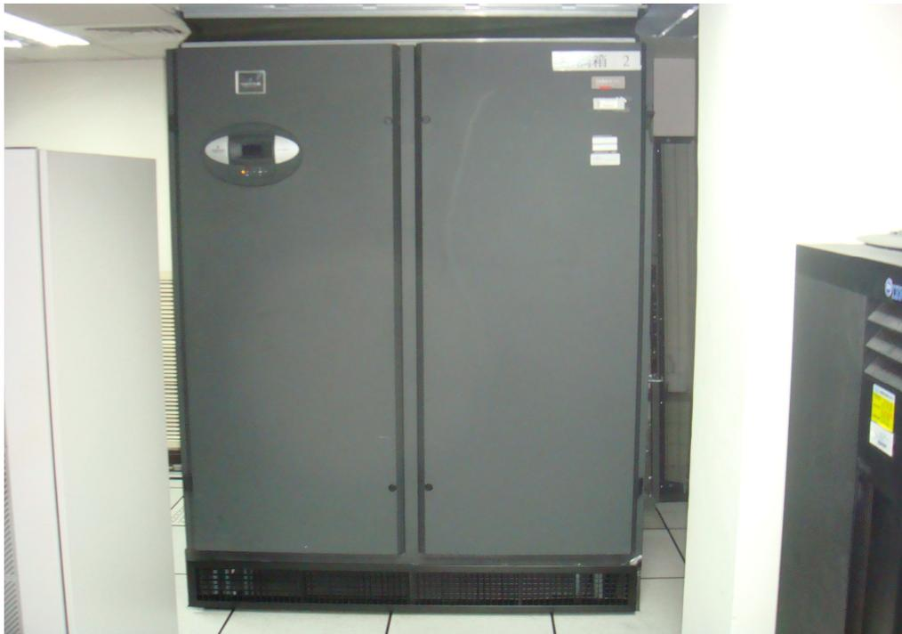
現有機房是利用高架地板出風方式冷卻所有設備，而機櫃區採取兩排並列擺設。如圖 3-2 紫色區塊為 4 台空調機、
